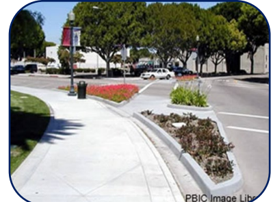
Eliminación del carril de acceso
